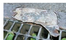
除雪ブレードによる破損
