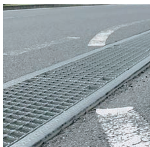
舗装下がりが発生してしまった箇所
