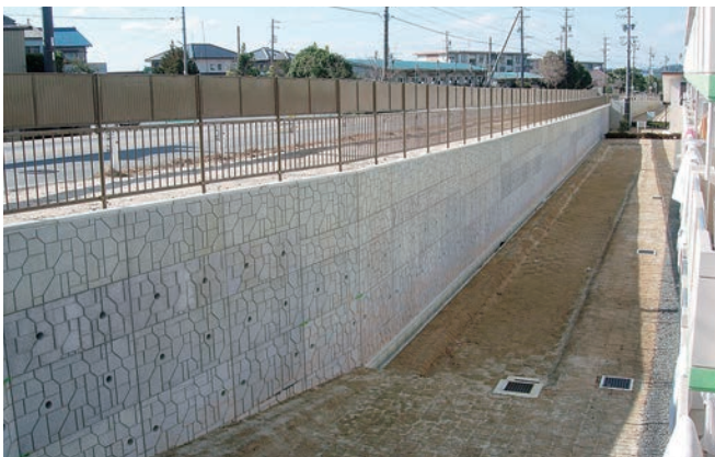
壁高=4500での施工例
