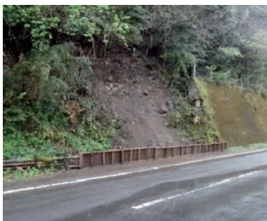
施工前：崩壊現場に仮設の木柵
