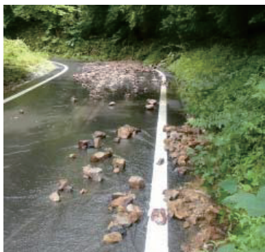
小規模落石の状況
