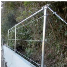
横ロープ設置完了
