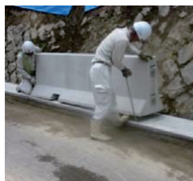
基礎擁壁の設置状況(1)
