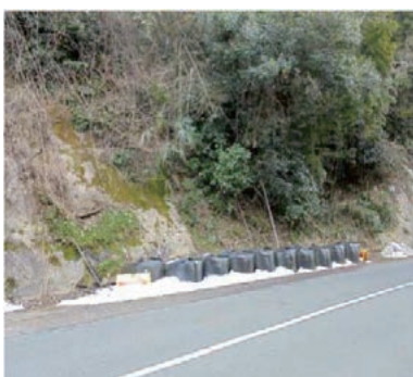
施工前：大型土のう
