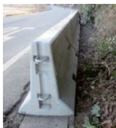
基礎擁壁の側面
