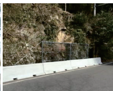
岩盤の剥離箇所に設置
