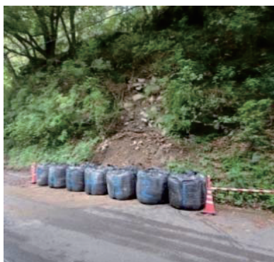
大型土のう対処事例
