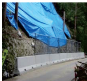
崩壊斜面下に仮設で設置
