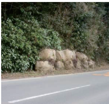
施工前：大型土のう
