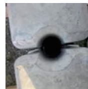
設置後に上から見た状態
