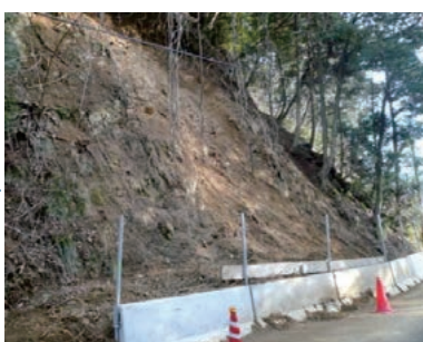
施工後：崩壊土砂を捕捉
