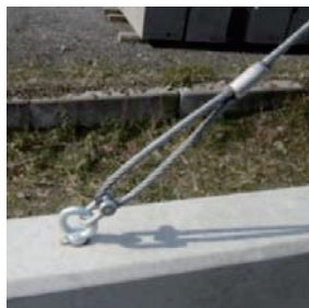
斜ロープと基礎擁壁を接続
