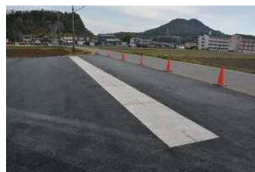
舗装後（設置完了）
