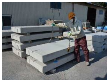
M16の専用吊り金具を2個使用します。
