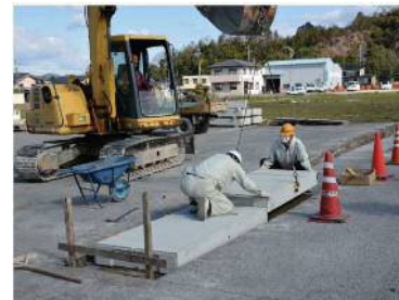
下部ブロック据付状況
