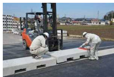
フォークリフトによる設置
