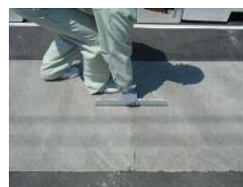
連結プレート設置
