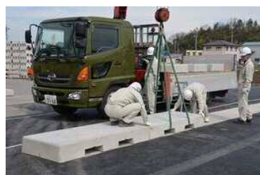
クレーンによる設置
