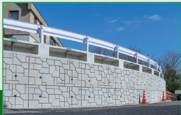
FP工法(フーチングレスパネル)との併用で道路幅員を最大限に確保。
